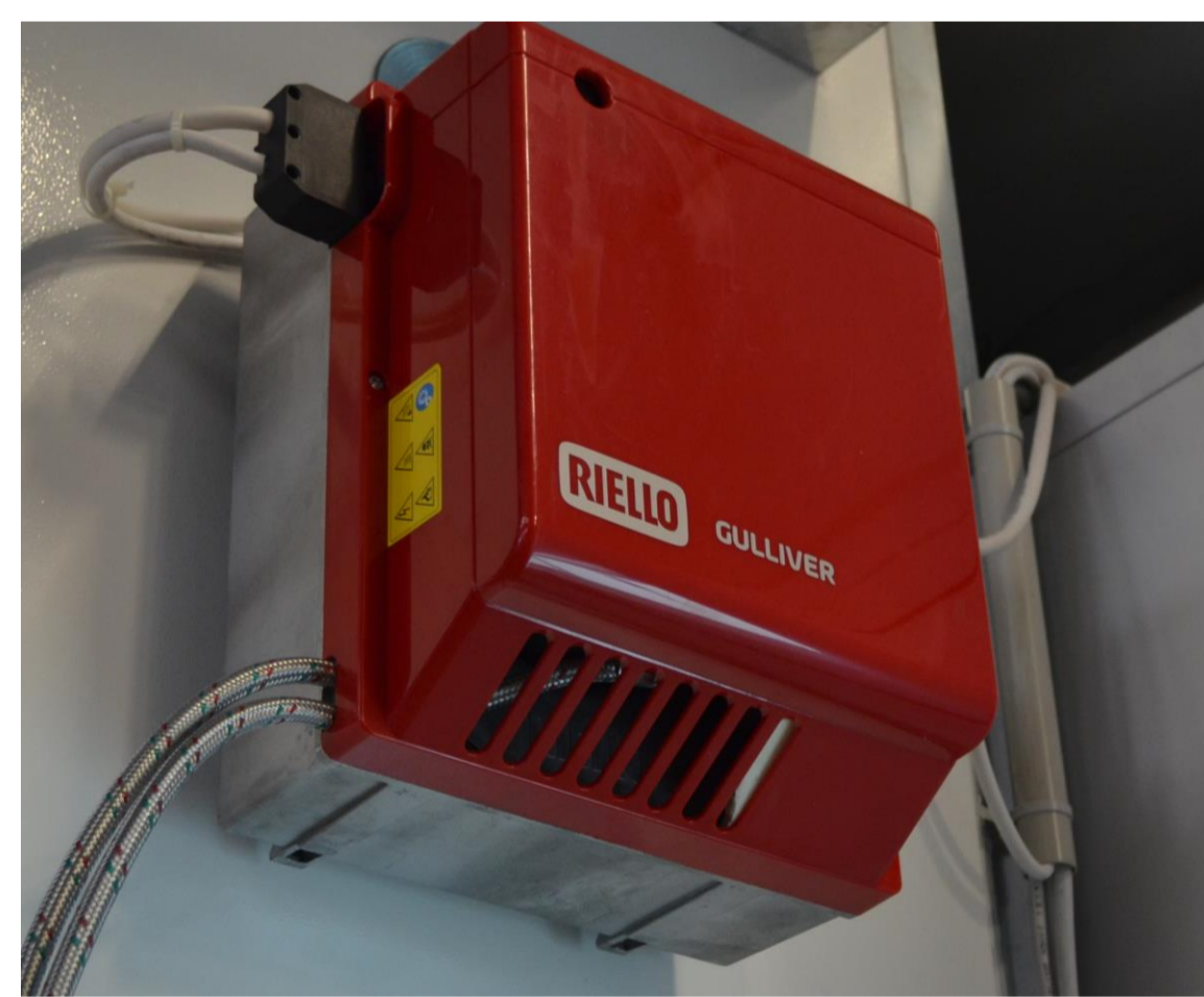
2 Brûleur Riello Fioul deux allures. T° de séchage max 70°C, Brûleurs Gaz, GPL en option
