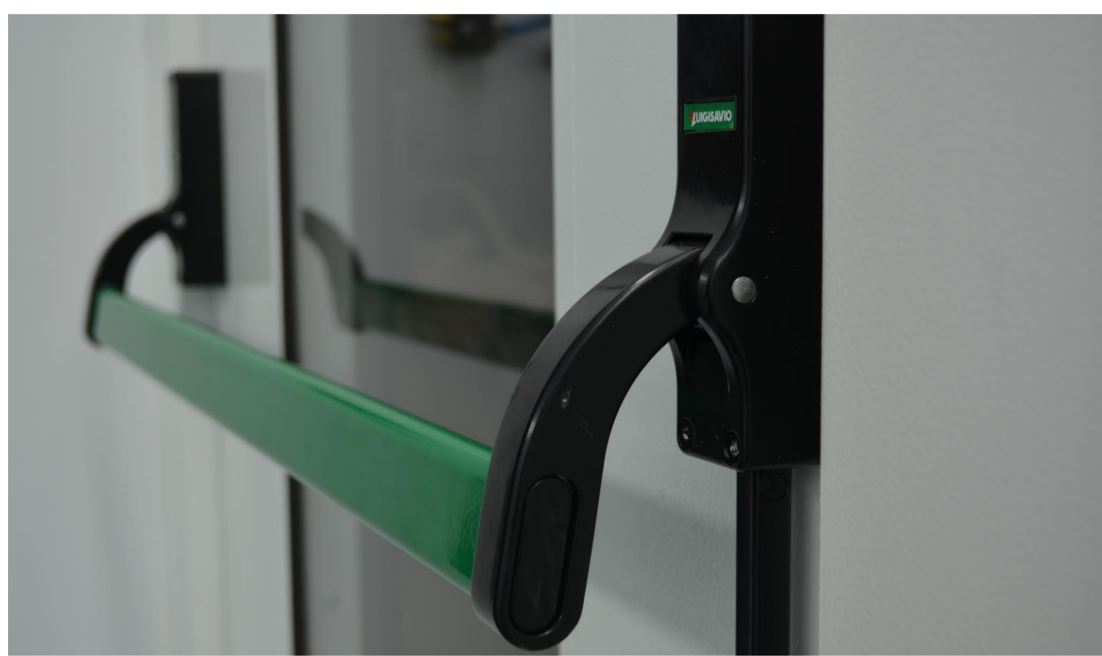
1 2 portes de service positionnées sur le côté avec vitrage en verre trempé et barre anti-panique.
