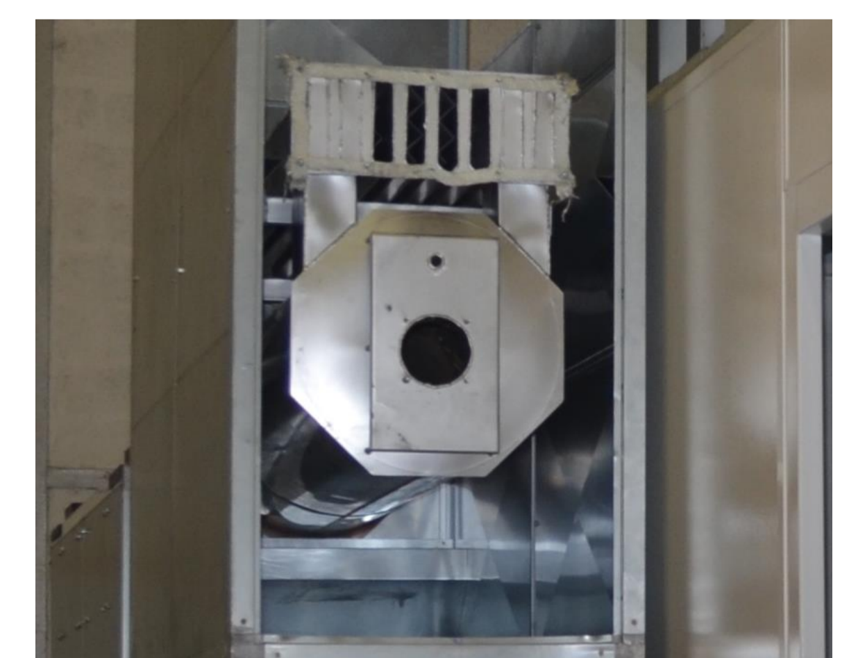
8 Échangeur thermique en inox de qualité 304 pour une restitution d'énergie à 85%
