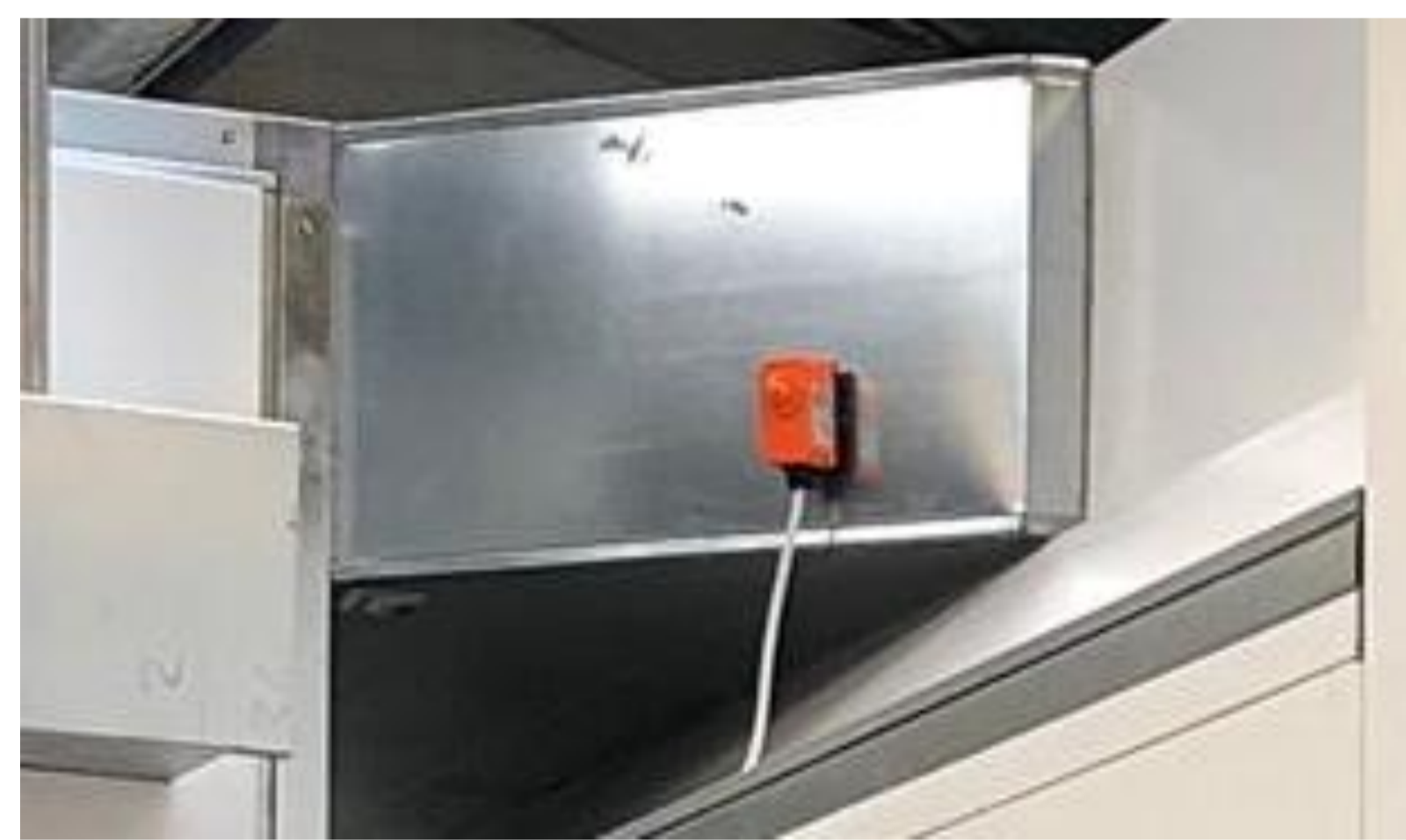
3 Thermostat de sécurité permet de couper le circuit électrique en cas de surchauffe de la cabine pour éviter les risques d'incendie.
