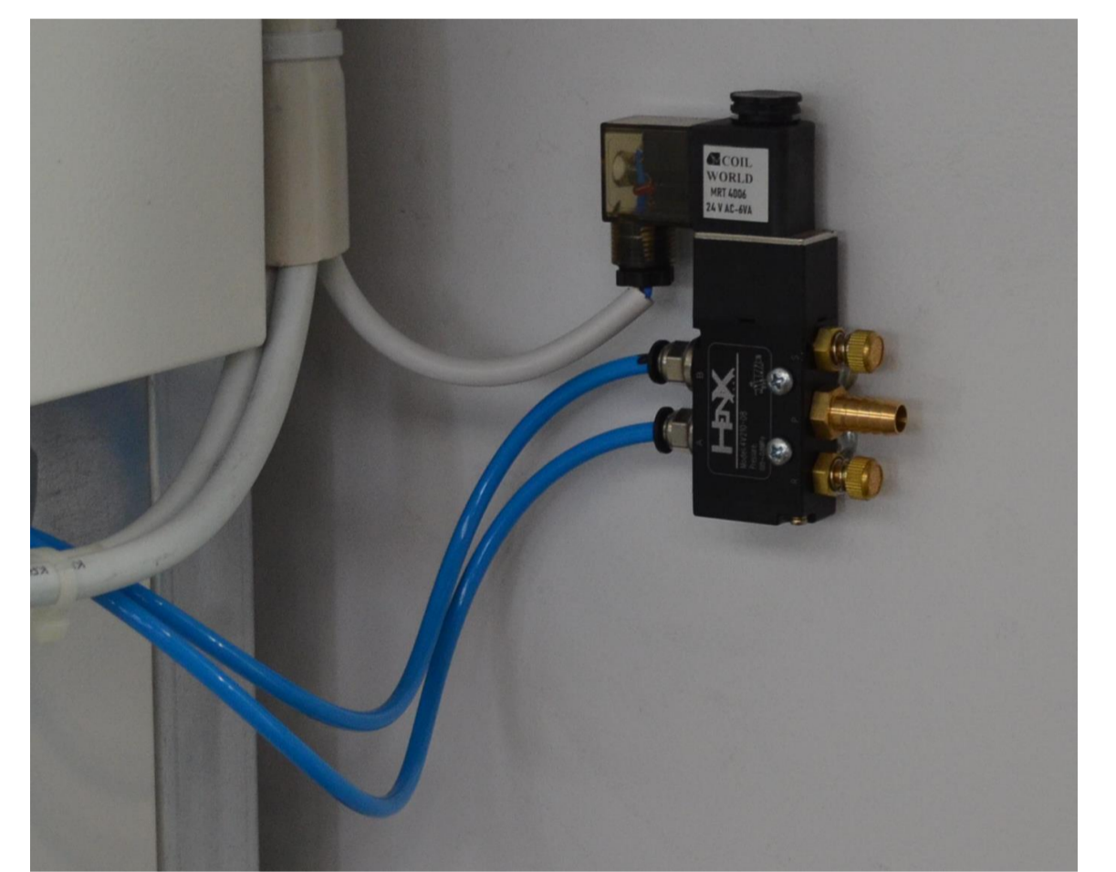
4 Volet pneumatique de recyclage d'air chaud commandé par électrovanne pour le passage en mode séchage.
