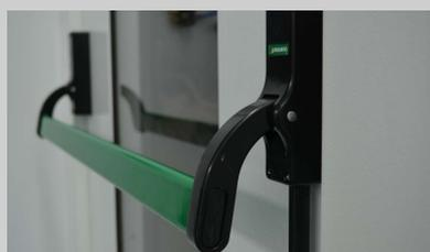
**1** Porte de service positionnée sur le côté avec vitrage en verre trempé et barre anti-panique.
