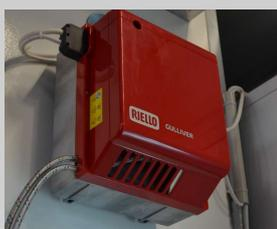
**2** Brûleur Riello Fioul une allure. T° de séchage max 70°C, Brûleurs Gaz, GPL ou deux allures en option
