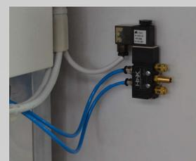
**4** Volet pneumatique de recyclage d'air chaud commandé par électrovanne pour le passage en mode séchage.
