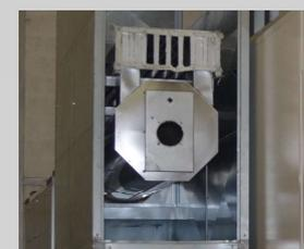
**8** Échangeur thermique en inox de qualité 304 pour une restitution d'énergie à 85%
