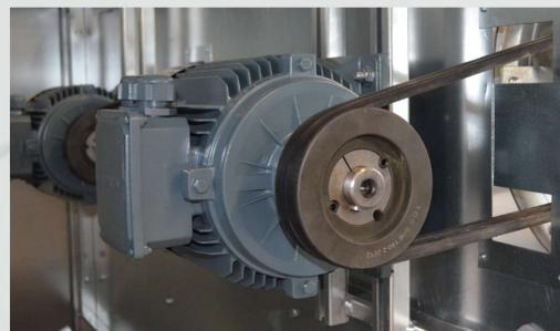
**7** 4 moteurs de 5,5 kW Gamak (ou Siemens en option) IE2 rendement élevé (IE3 premium en option). Couplage poulie moteur
