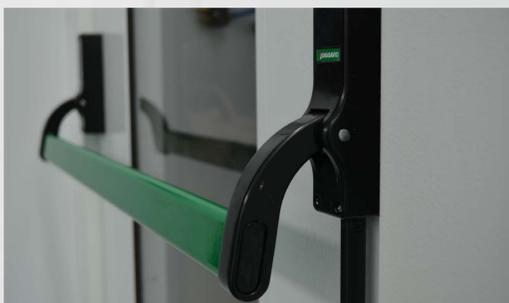
**1** Porte de service positionné sur le côté avec vitrage en verre trempé et barre anti-panique.
