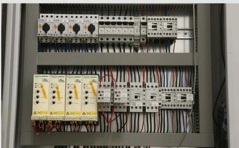
**5** Armoire électrique sécurisée avec bouton d'arrêt d'urgence coup de poing, composants européens de qualité : Schneider, Eaton, Delta... Démarrage progressif par soft-starter. Variateur de tension en option
