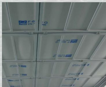
**2** | Système de filtration au plafond avec cassettes pour un changement des filtres simple et rapide
